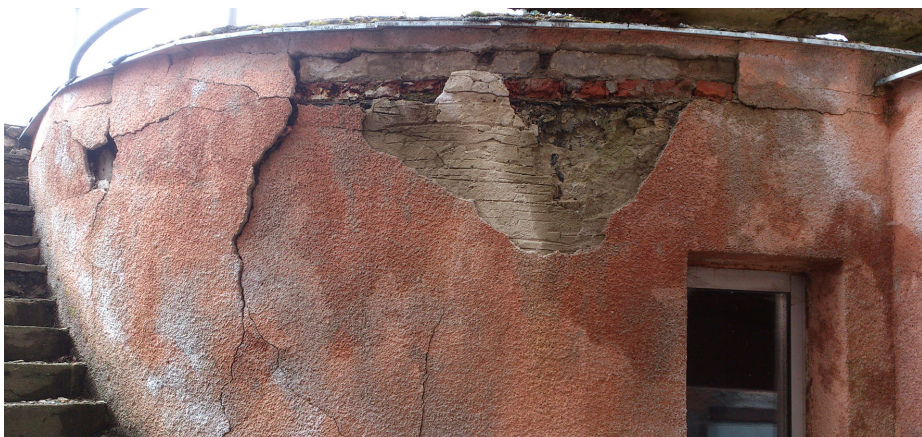
Výstup na podium na Svýdnýckom amfiteátri
